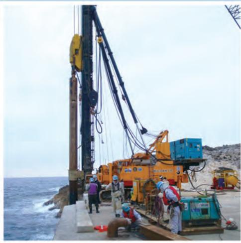
北大東村(きただいとうそん)は、沖縄本島の東方約360kmに位置する沖縄県最東端の北大東島と沖大東島を行政区画とする沖縄県の村です。2003年に着工した北大東島北港の岸壁工事では、主に嵩上げ行ないました。用いられた工法は鋼管中掘工。海岸沿いの硬質な地盤という過酷な状況の中で、弊社が培ってきた長年のノウハウや技術力を生かした施行となりました。
